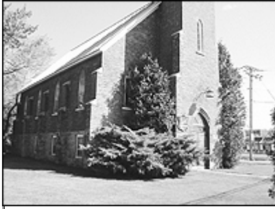
L'église presbytérienne située au 57, rue Dufferin a été vendue et changera de vocation puisqu'elle deviendra un centre d'escalade intérieur à partir de l'automne prochain. (Photo : Le Journal)
